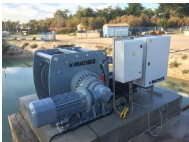
► Treuil électrique INDUSTRIA utilisé pour manœuvrer la porte d'un barrage sur une voie navigable.
