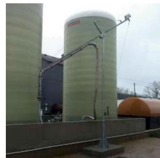
△ Déploiement d'un bras de chargement.
